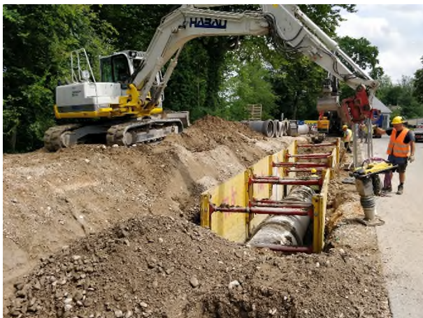
Abb. 3 und 4: Im Anschluss an den Einbau der Spundwand bringen Arbeiter an der Saalachstraße in Bad Reichenhall einen Ableitungskanal ein.
