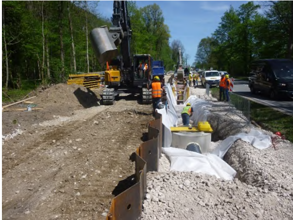
Abb. 1: Maßarbeit: Auf engstem Raum bauen die Arbeiter entlang der B20/21 in Bad Reichenhall die Spundwand und das Drainagesystem für den Deich ein.
